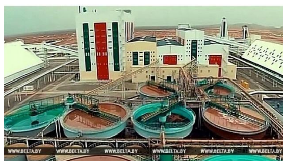
図 4. Garlyk 加里工場の浮遊選鉱設備
